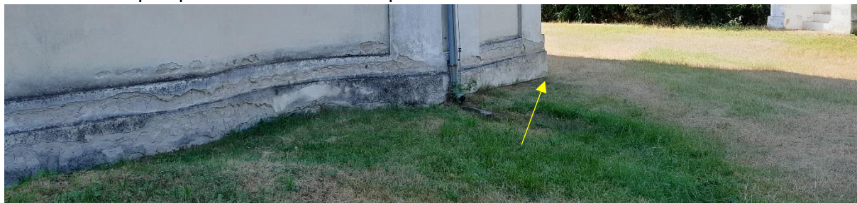
Odhalená pata stěny u terénu bez izolace usnadňuje pronikání povrchové vody do zdiva
