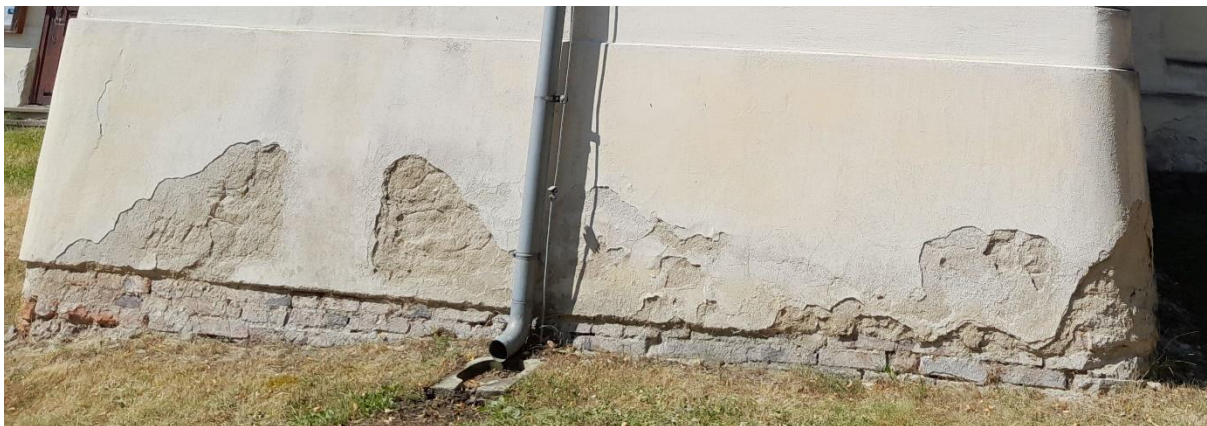
Při příválu se zahltí dešťový svod a srážky přetékají přes hranu podokapního žlabu po celé délce sakristie
