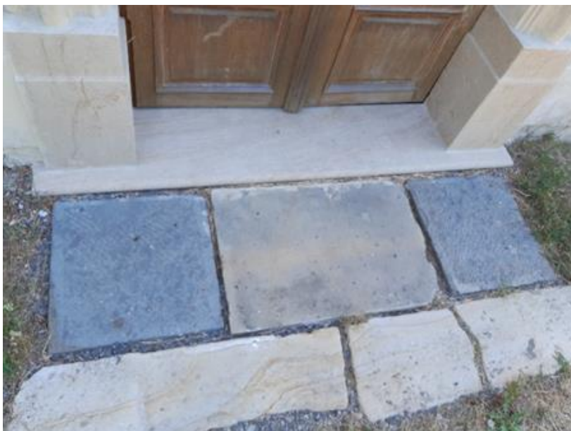
Nový práh s neutěsněnými spárami mezi dlažbou a prahem a jednotlivými deskami kamenné dlažby usnadňuje pronikání přívalové vody do spodních souvrství a pod práh dovnitř objektu
