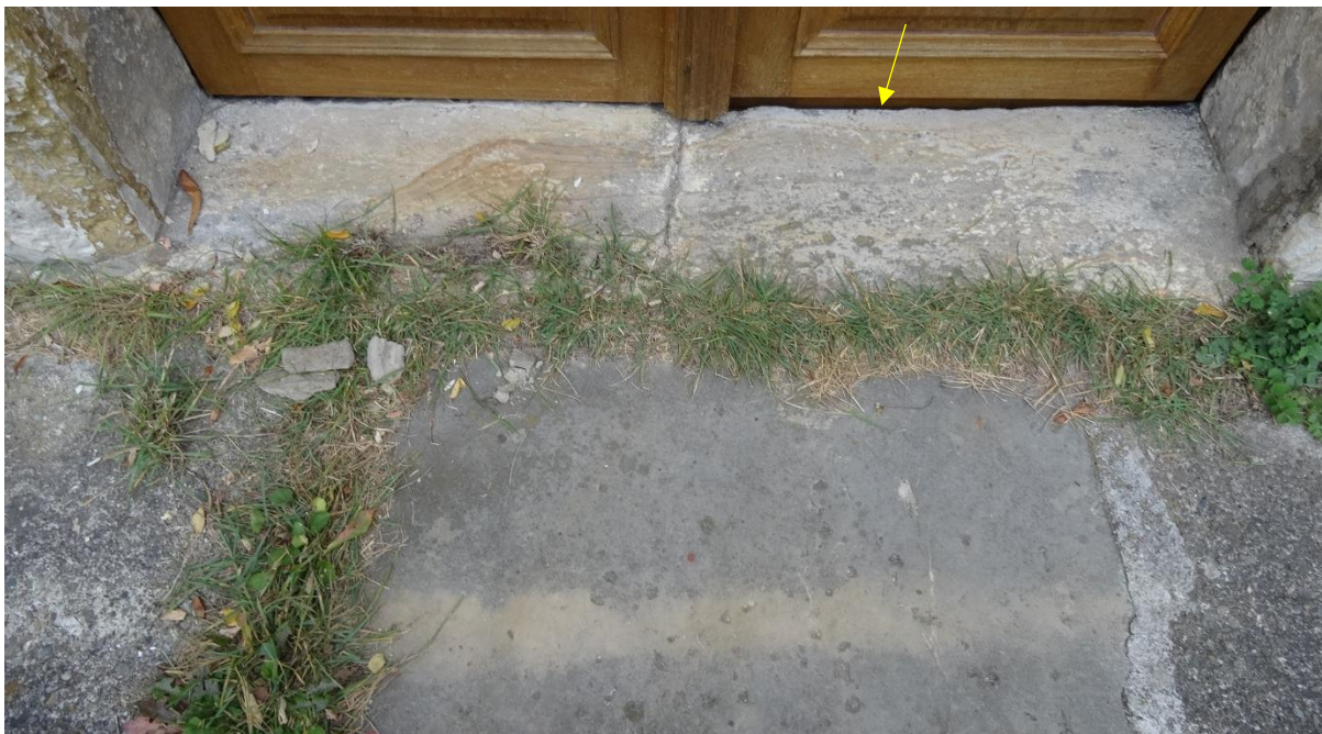
Prošlapaný původní práh byl v úrovni původní venkovní dlažby, přívalové deště stékaly z plochy svahu přímo na podlahu kostela mezerou pode dveřmi. Tráva zde zarůstá do spár a částečně je chrání před přímým zatékáním povrchovou vodou
