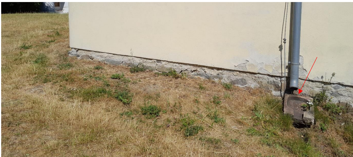
Ostříková vlhká skvrna u neutěsněné paty zdi kolem kamenného žlabu
