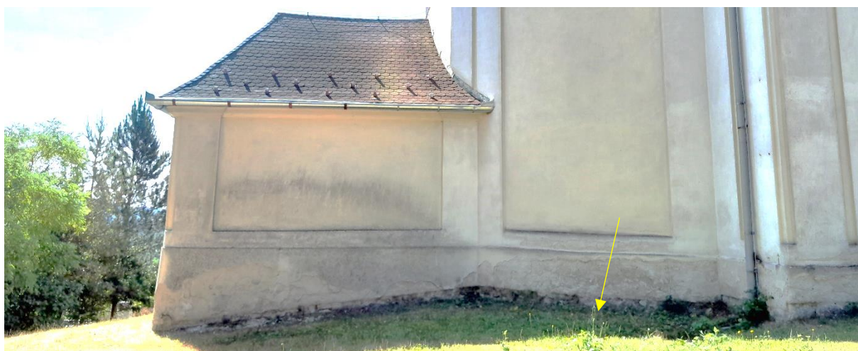
Odhalená pata stěny u terénu bez izolace usnadňuje pronikání povrchové vody do zdiva
